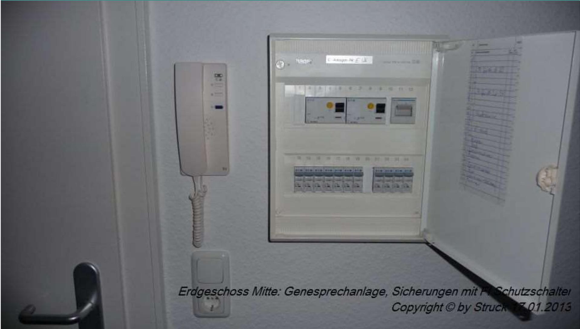
*Erdgeschoss Mitte: Genesprechanlage, Sicherungen mit FI-Schutzschalter
